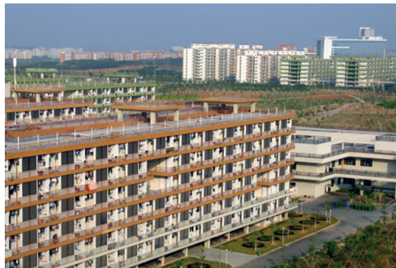
Abbildung 5.5-5 Großflächige Wohnbauprojekte in Guangzhou. Quelle: Frauke Kraas/WBGU
